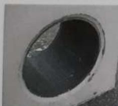
Fertig erstellte, lunkefreie, monolithisch gegossene Wanddurchführung – fachgerechter Einbau und Verdichtung des Betons vorausgesetzt.
