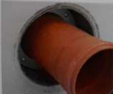
**4.** Eingesetzter Dichtsatz mit montiertem Medienrohr.
