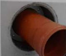
**4.** Eingesetzter Dichtsatz mit montiertem Medienrohr.
