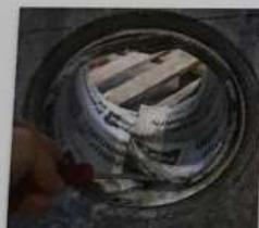
**3.** Das Ausschalen der Permur Monolith-Schalung soll spätestens nach 2-3 Tagen erfolgen (Trennleiste herausnehmen und Monolith-Schalung entfernen).
