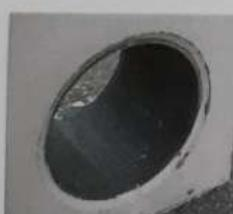
Fertig erstellte, lunkerfreie, monolithisch gegossene Wanddurchführung – fachgerechter Einbau und Verdichtung des Betons vorausgesetzt.
