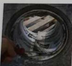
**3.** Das Ausschalen der Permur Monolith-Schalung soll spätestens nach 2-3 Tagen erfolgen (Trennleiste herausnehmen und Monolith-Schalung entfernen).
