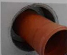
**4.** Eingesetzter Dichtsatz mit montiertem Medienrohr.
